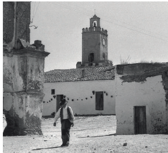
Fig.9 - Torre do Relógio vista do interior do Castelo, Diogo Margarido, 1958.
