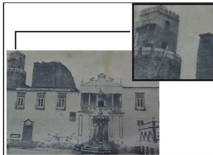
Fig.7 - Obras de arranjo e recolocação do relógio, 1926.
